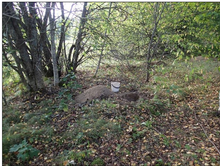
Kuva 10. Kuvaussuunta länteen. Rakennuksenperustan alue. Valkoinen ämpäri on koekuopan 1 kohdalla. Kuvan oikealla taka-alalla erottuu koekuoppien 2 ja 3 maakasat.
